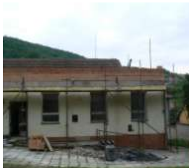
Oprava střechy na budově bývalé školy
